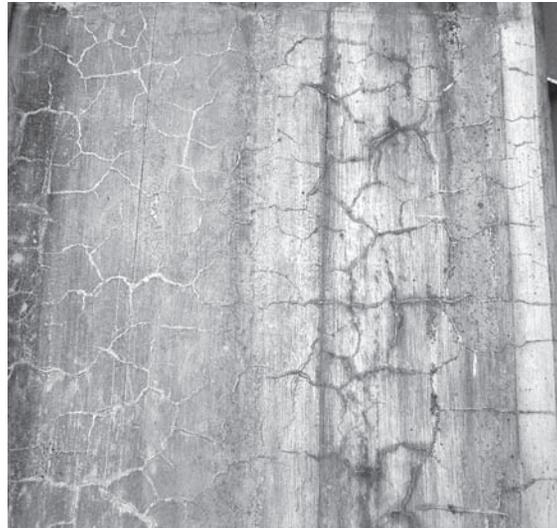
写真 柱に生じた乾燥収縮ひび割れ
