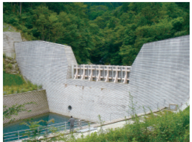
図5 長又第2堰堤全景写真
